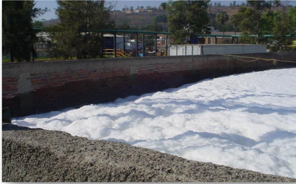
شكل رقم (1) وجود رغاوى بيضاء بأحواض التهوية في بداية التشغيل
