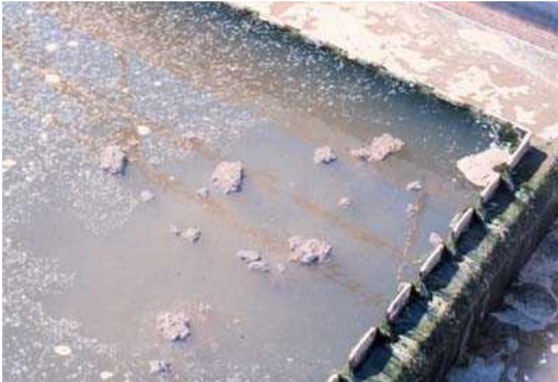
شكل رقم (6) وجود فقاعات غاز النيتروجين بالحمأة وطفوها على السطح
