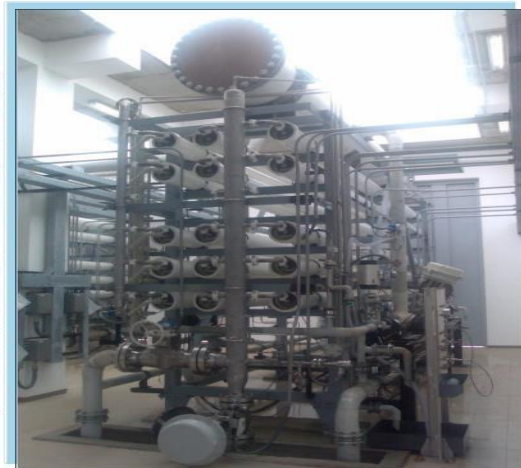
الشكل 21 : جانب من إحدى وحدات التناضح العكسي
